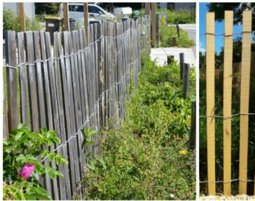
01 - Clôture en ganivelle châtaignier à lattes sciées (espacement 2/4cm) des ilots privés installée en limite d'espace public par l'aménageur sur l'espace privé. Hauteur 1.20m.
