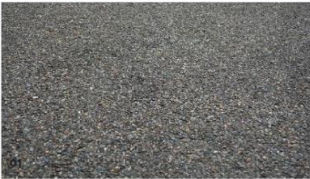
Enrobé sans bordures
