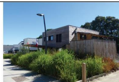
Exemple de flore naturelle des fossés. Ensemencement naturel des noues ou végétalisation par semis de mélange prairial.
