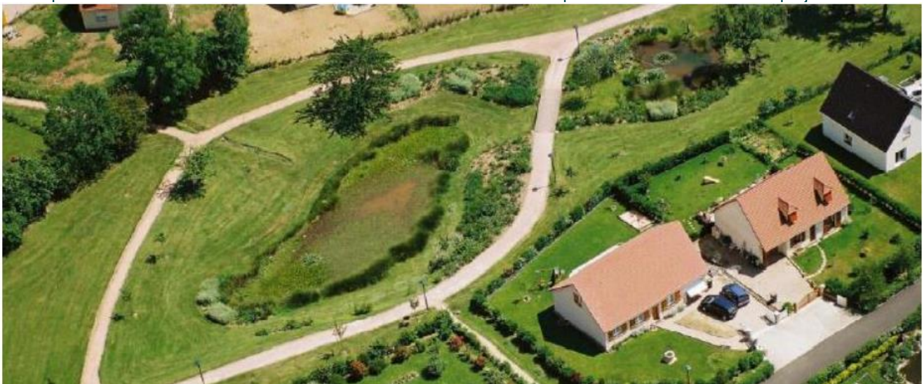
Figure 16 Exemple de réalisation d'espace vert creux (Source : Banque photo INFRA Services)
